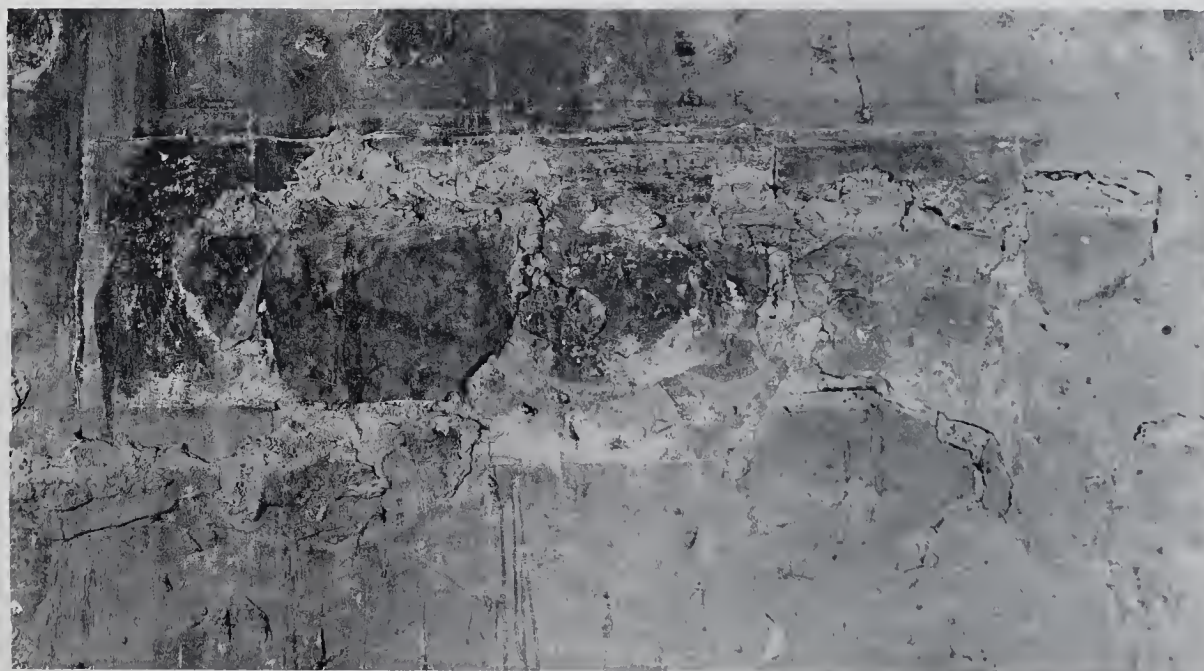
2. — QEŞEİR 'AMRA. - Le piteux état du tableau historique sur la paroi occidentale de la salle A.
