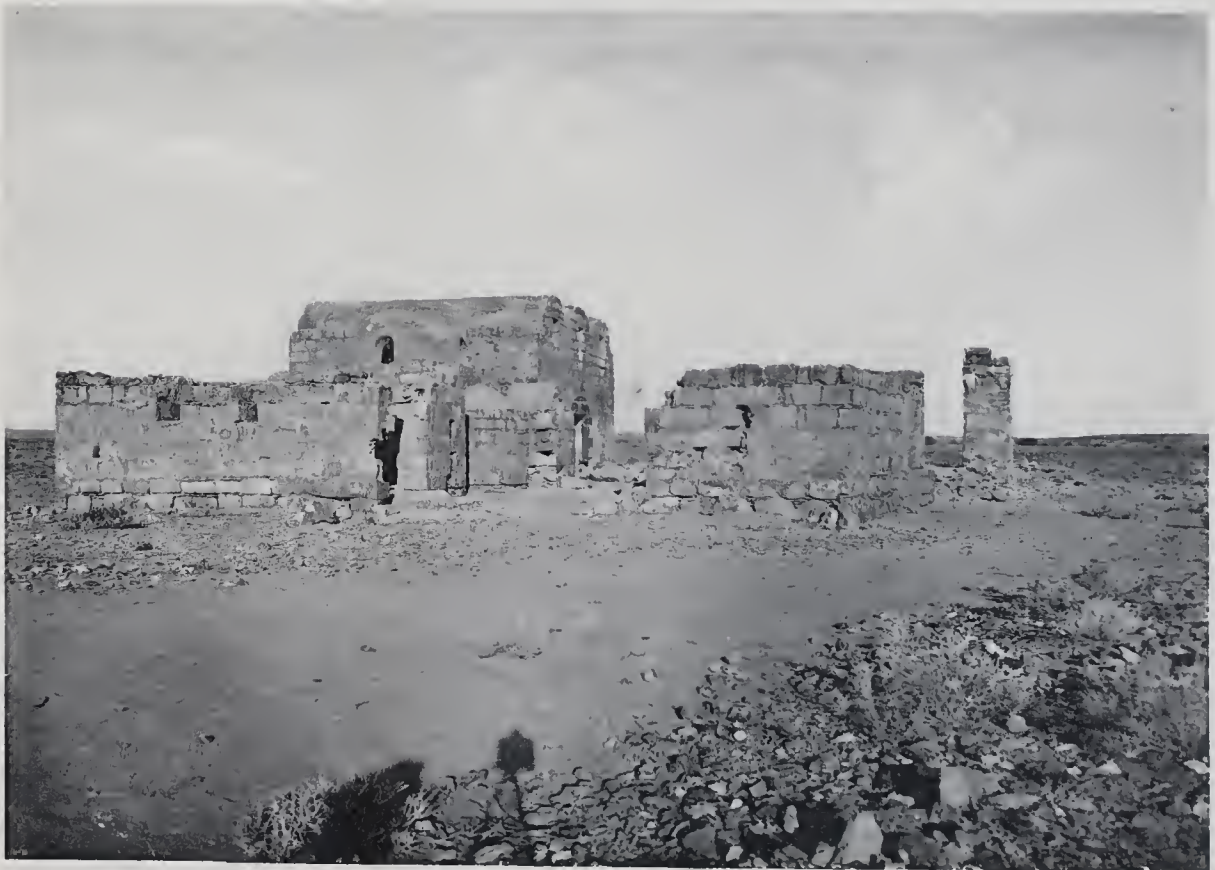
2. — QEṢEIR ĀMRA - Vue prise du Nord-Est.
