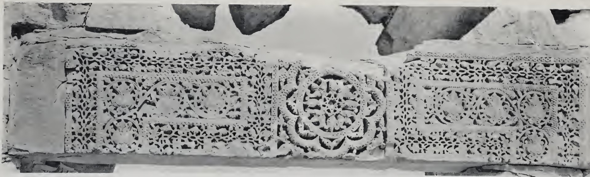
1. — QASR ET-TÛBA. - Linteau de la porte de la chambre B.
