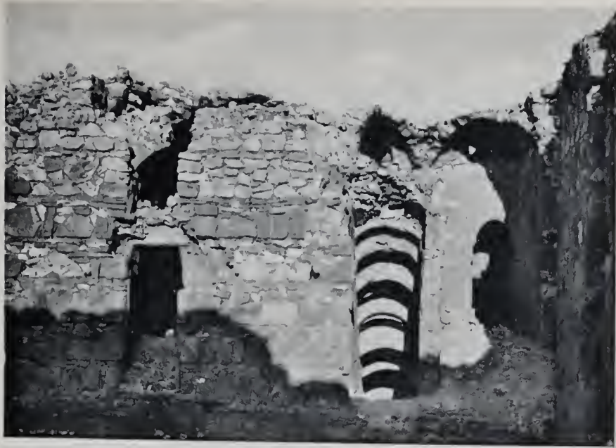
1. — QASR-HARÂNEH. - Vue des arceaux supportant l'escalier de la terrasse.
