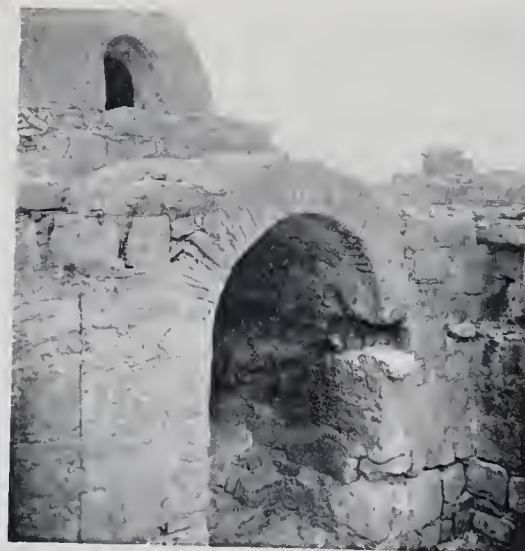
2. — QEṢEIR ĀMRA. - Entrée du corridor G, à l'Est.
