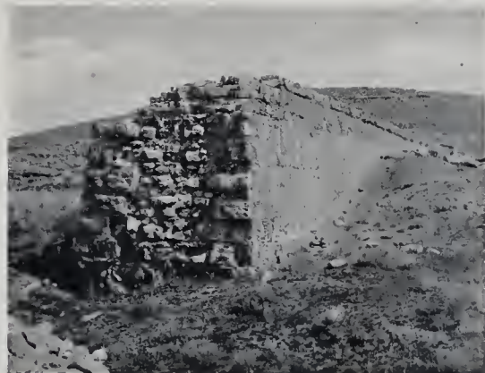
2. — QANÂTIR ES-SAKER. - Digue rompue.
