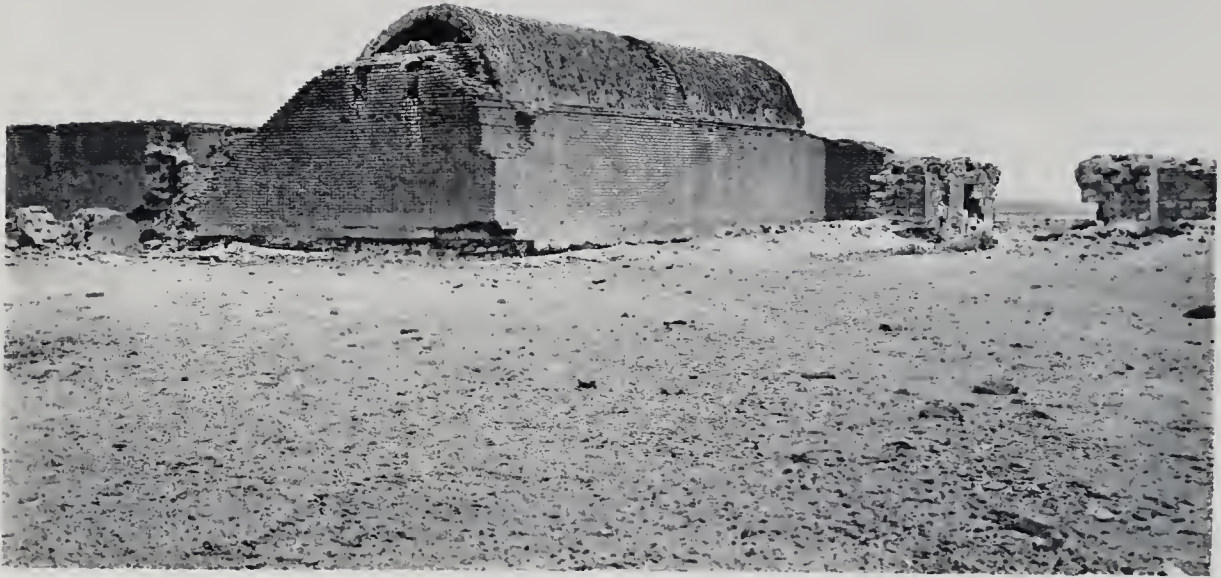
1. — QAṢR ET-ṬŌBA. - Vue générale des salles O et O' prise du S.-E. ; à droite, la porte C.
