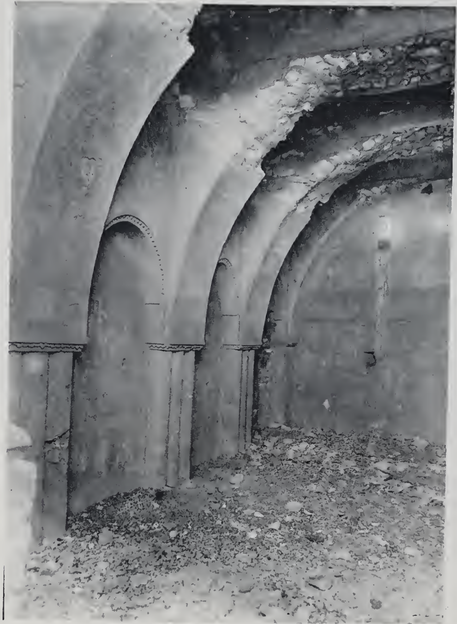
3. — QASR-HARÂNEH. - Intérieur de la salle 29, paroi orientale.
