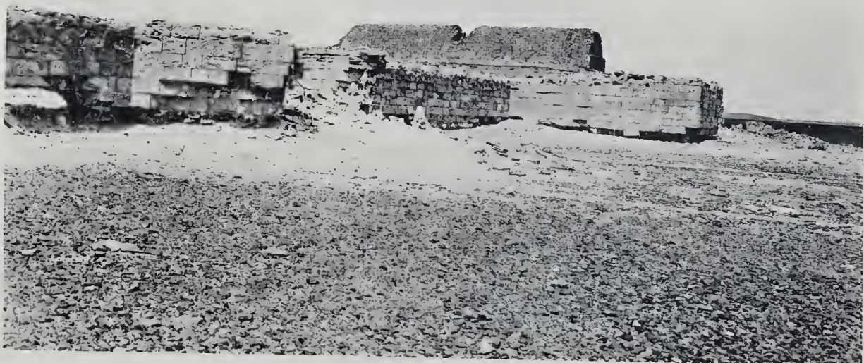
2. — QASR ET-TÛBA. - Extérieur de la chambre B'; N.-E; section enceinte Nord et grosse tour D.
