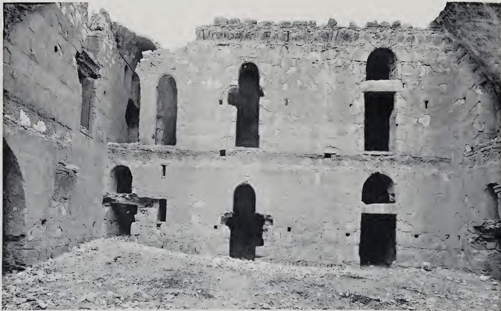
QASR-HARÂNEH. - Dans la cour du château, côté Ouest et angle Sud-Ouest.
