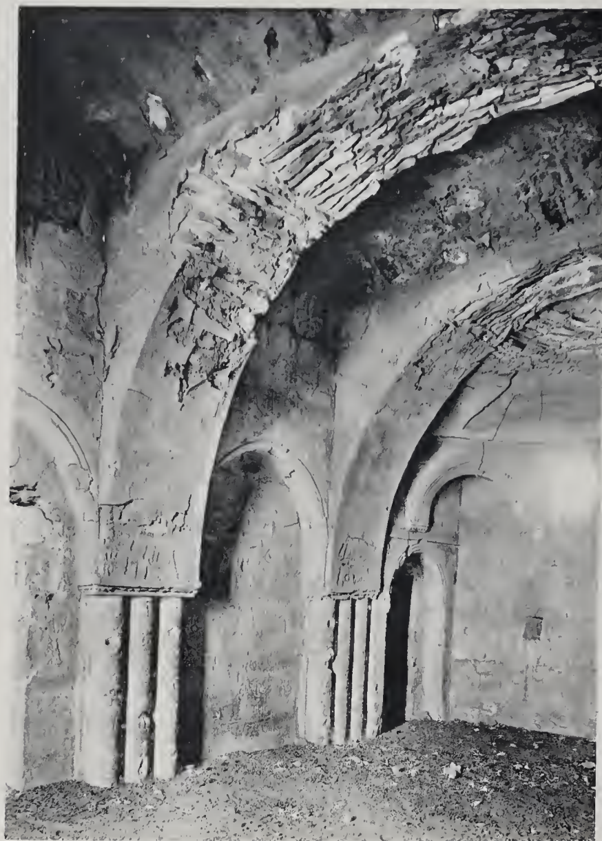
2. QASR-ĤARÂNEH. - Angle S.-O. de la salle 51. - Structure des grands arceaux.
